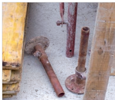
Tipologie di basette tradizionali di tipo fisso e regolabile
