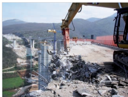
Demolizione mediante cesoie e martellone
