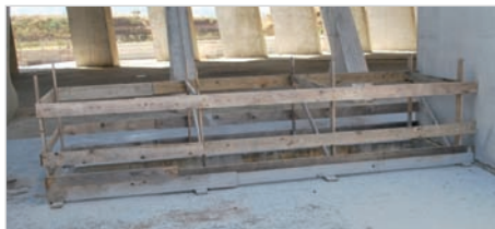
Parapetti provvisori a protezione di fori nei solai
