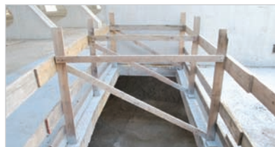
Parapetti provvisori a protezione di fori nei solai
