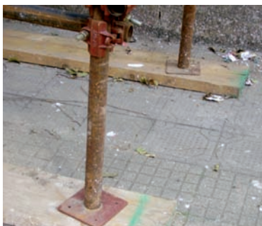
Tipologie di basette tradizionali di tipo fisso e regolabile
