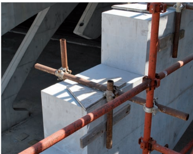
Esempio di ancoraggio a cravatta
