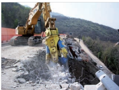
Demolizione mediante cesoie e martellone
