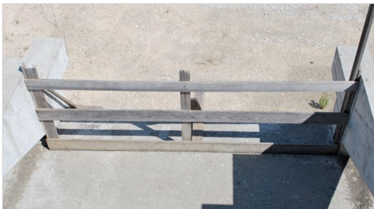
Parapetto provvisorio a protezione di una zona prospiciente il vuoto
